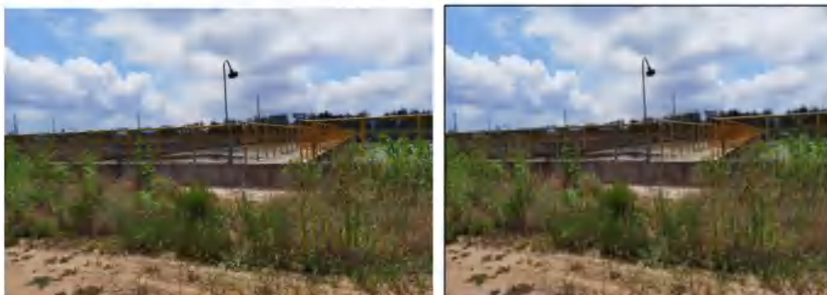
图 2.5-27 雨水提升池、事故水池
