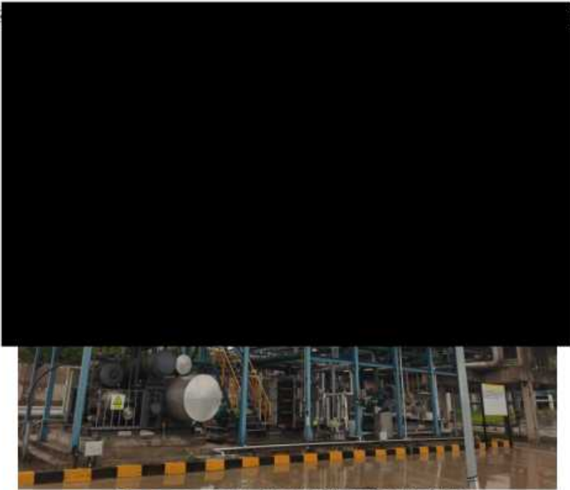
图 2.5-13 火车、汽车栈台油气回收设施
