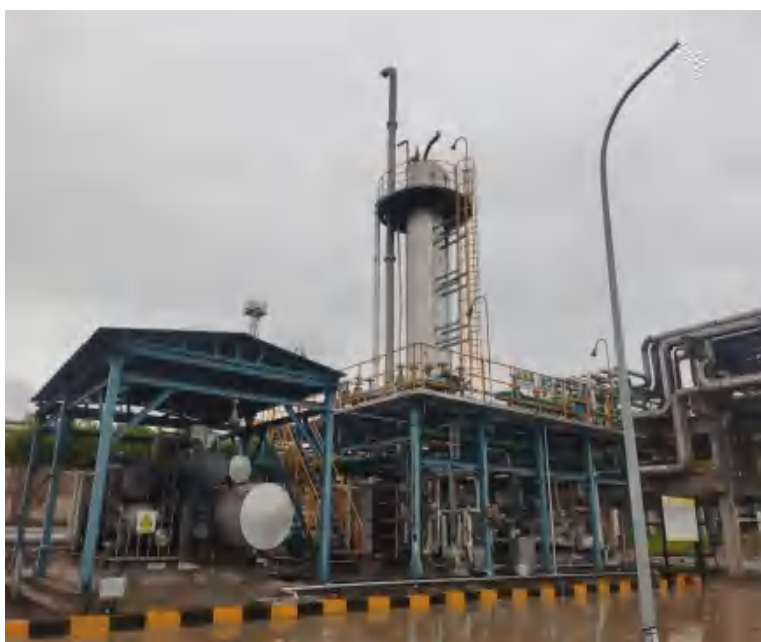
图 2.5-13 火车、汽车栈台油气回收设施
