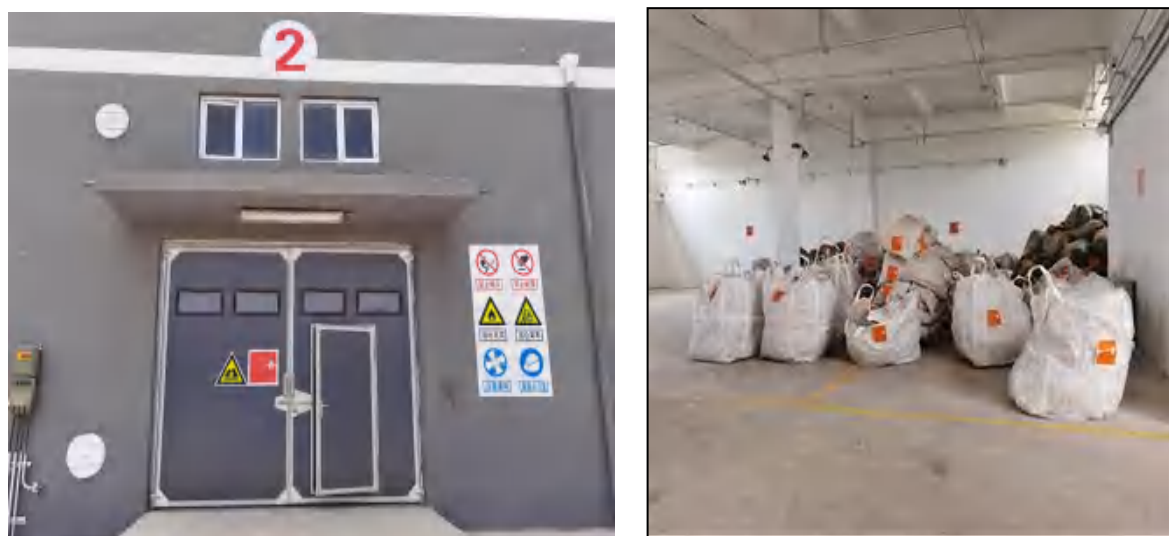
图 2.5-23 厂内现有危险废物贮存库
