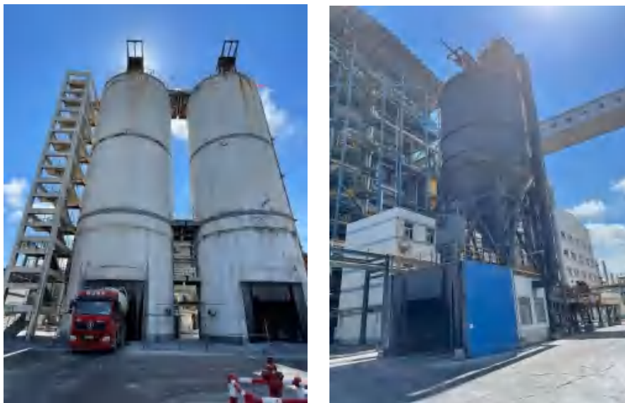
图 2.5-24 CFB 锅炉灰库、渣库
