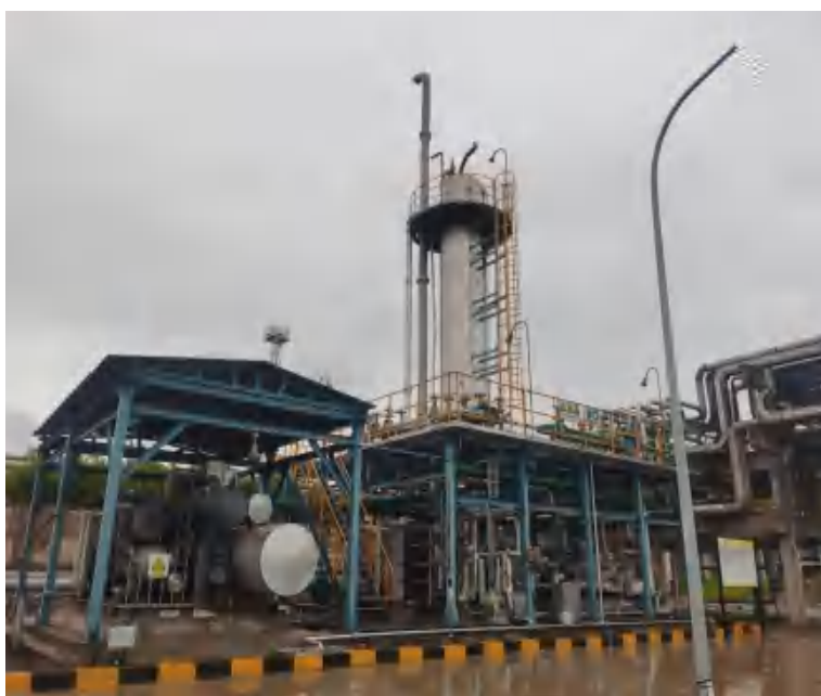
图 2.5-13 火车、汽车栈台油气回收设施
