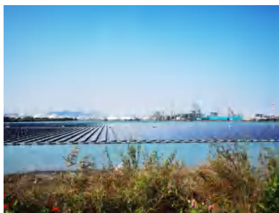
厂址外右侧水面光伏
