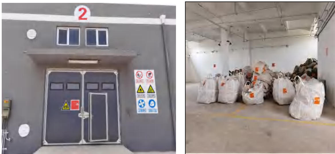
图 2.5-23 厂内现有危险废物贮存库
