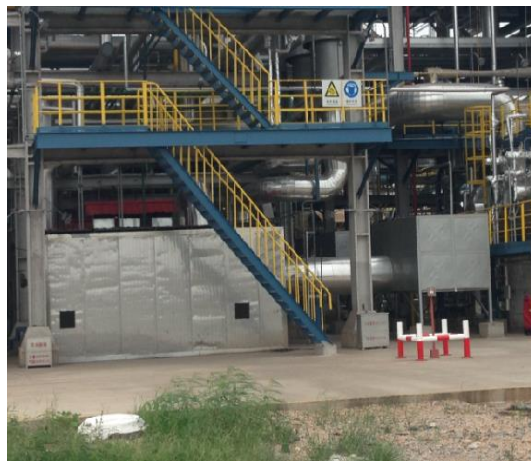
制硫鼓风机隔声罩
