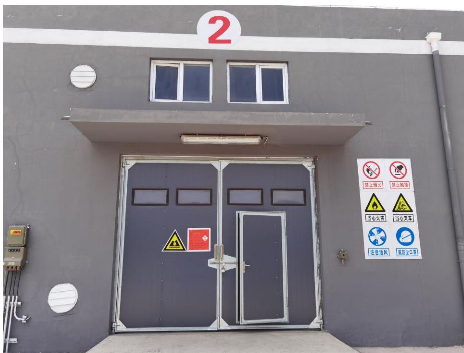
图 4-2 青岛炼化危废暂存库
